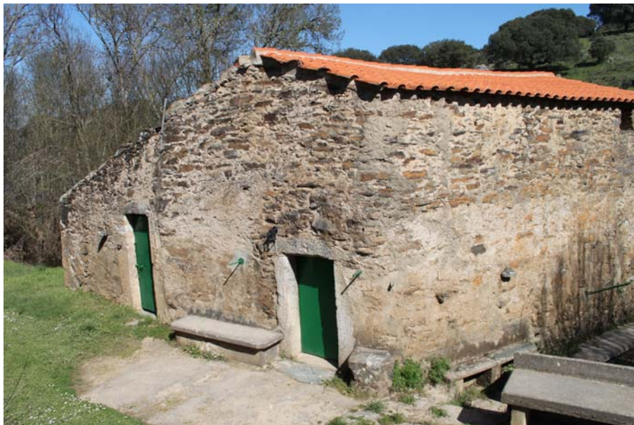
Vista general del molino
