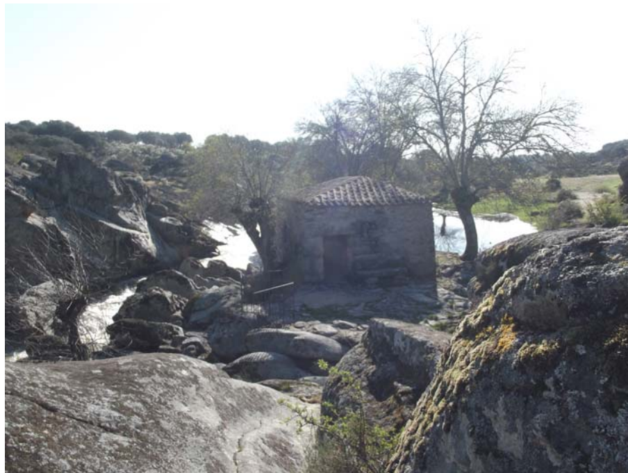
Vista general del molino
