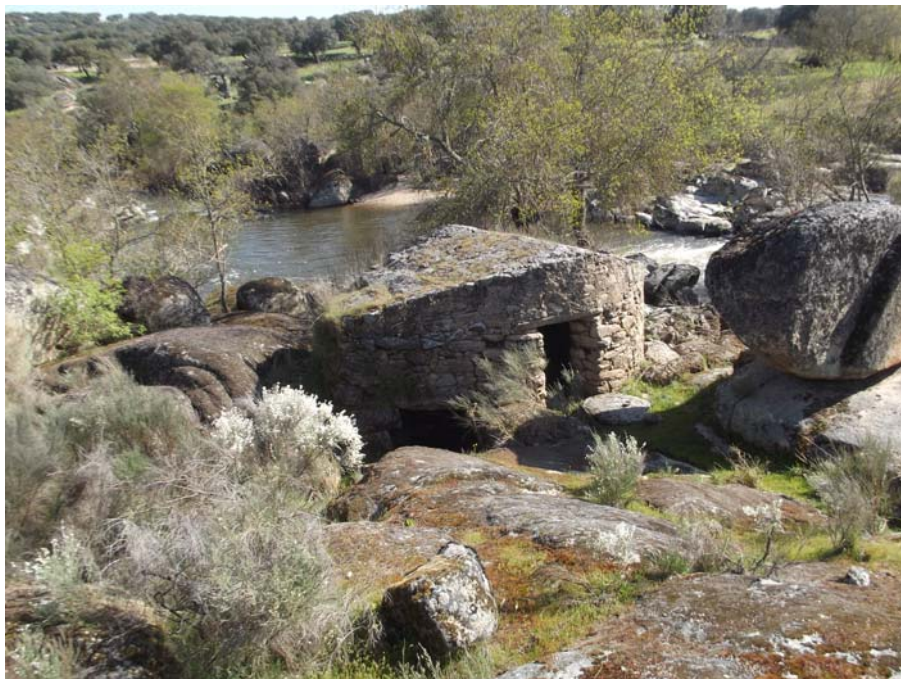
Vista general del molino
