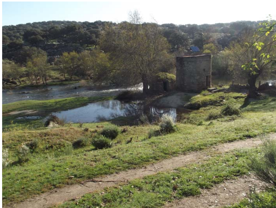
Vista general de ambas construcción desde el Sur
