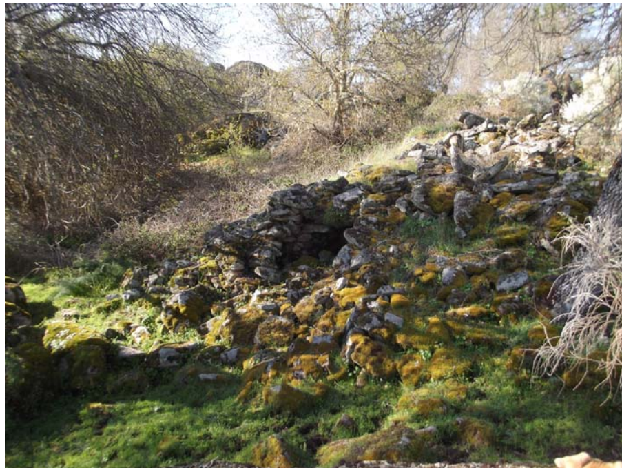
Molino muy destruido junto al arroyo
