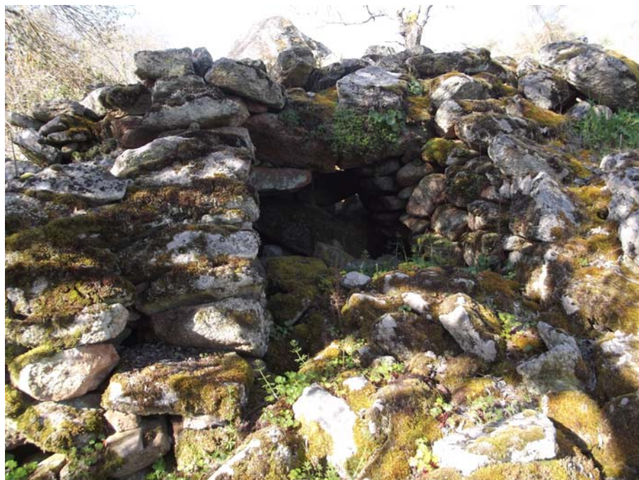
Detalle de la puerta de entrada de dicho molino
