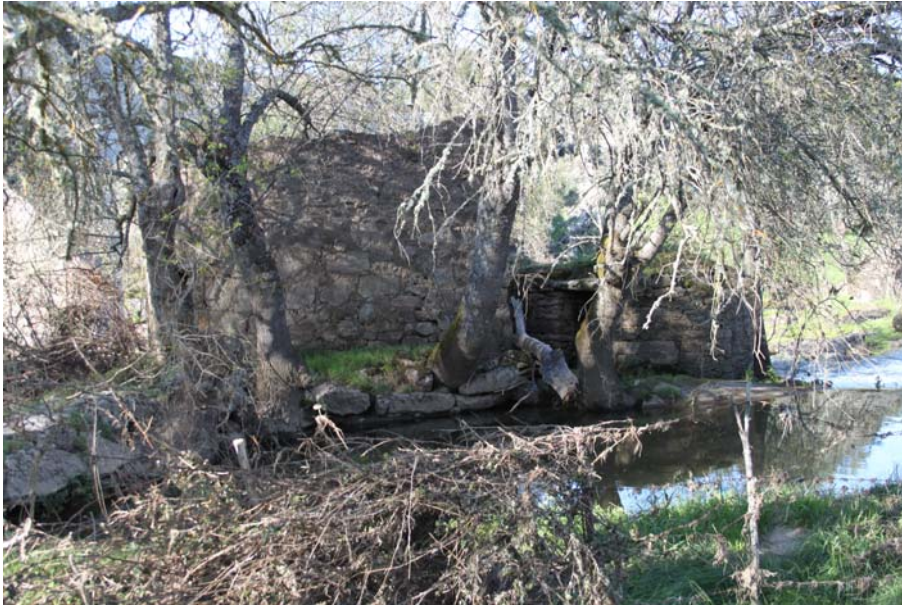
Vista general de ambos molinos
