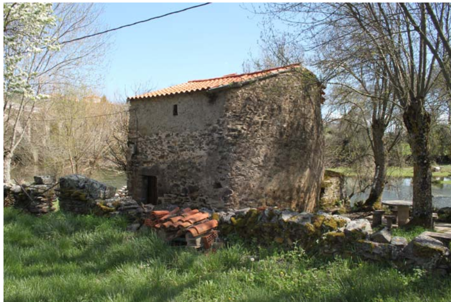
Vista general del molino
