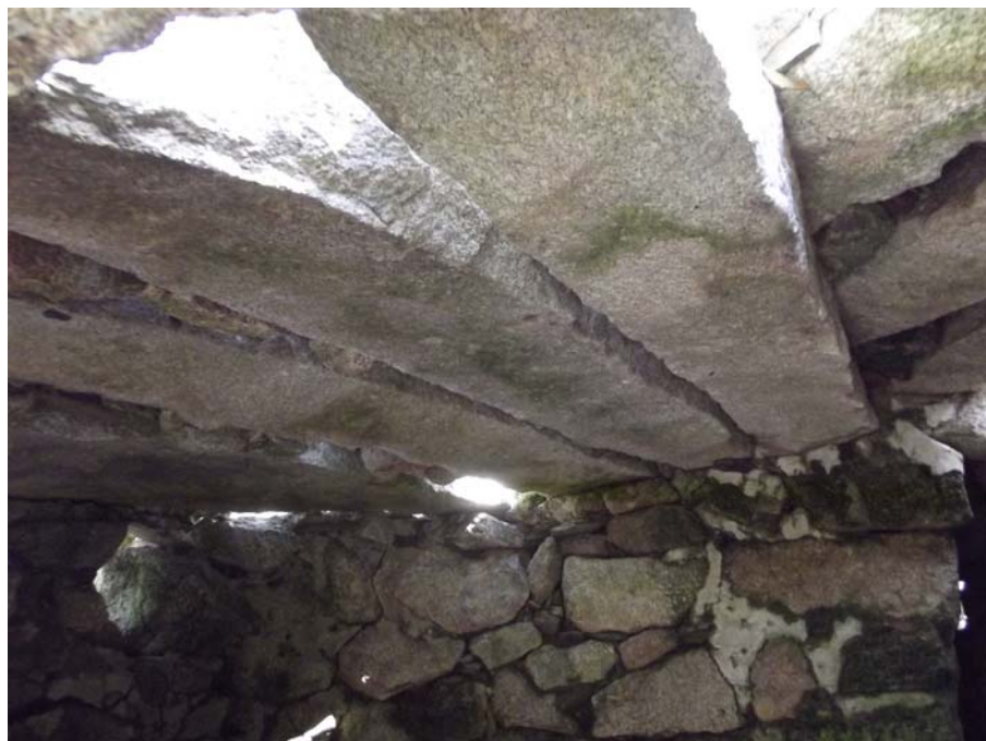
Detalle de las lanchas que forman el techo
