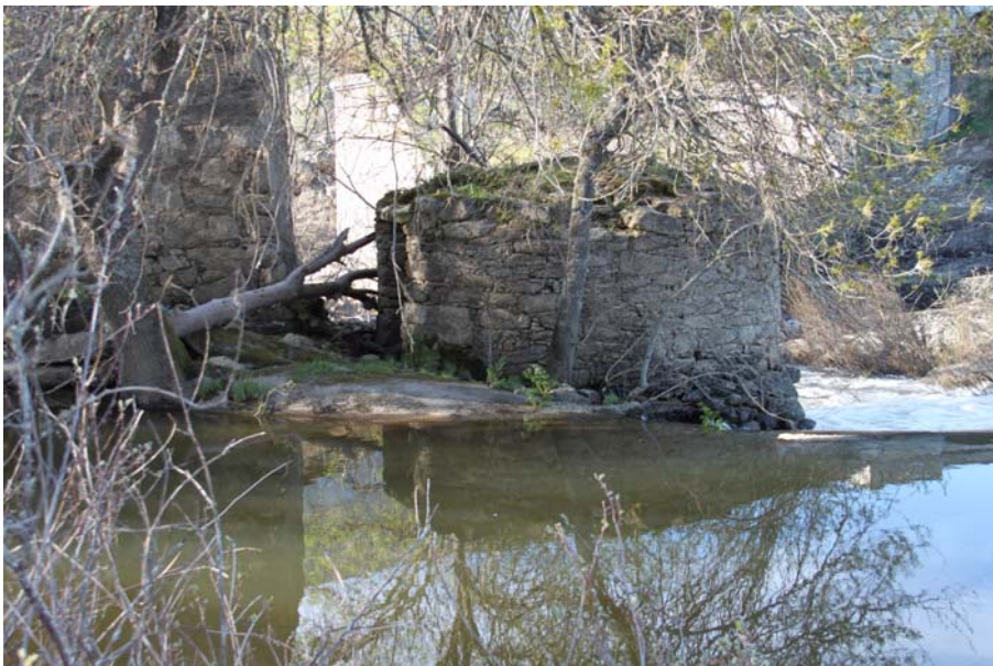
Vista general de ambos molinos
