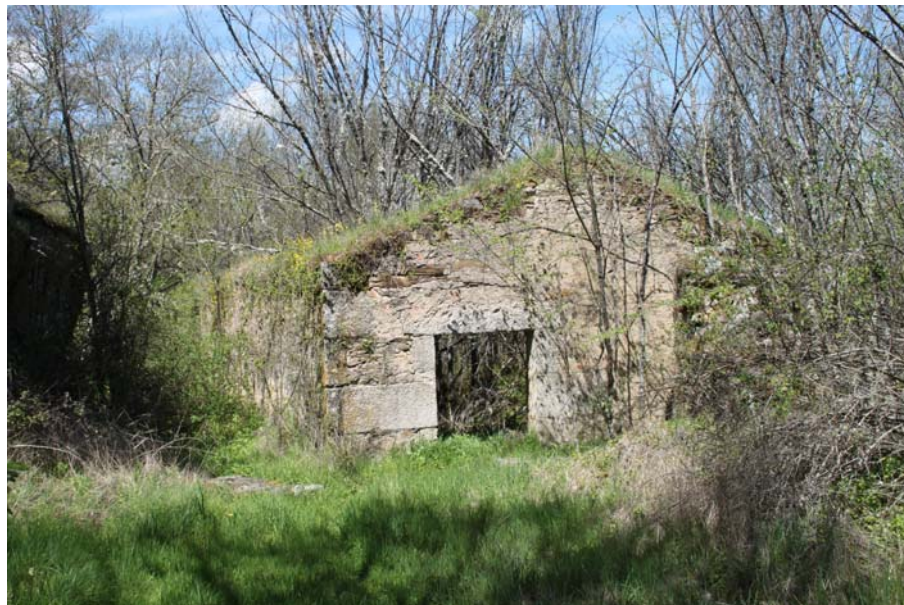
Detalle de una de las naves de la fábrica
