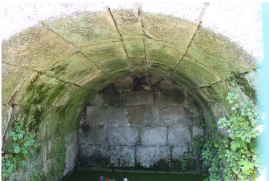
Detalle del interior
