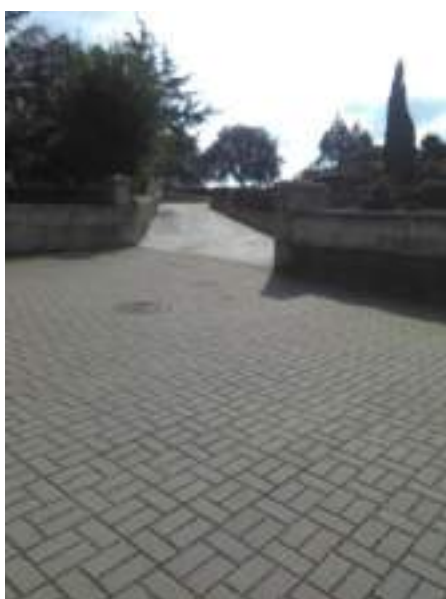
Renovación de la red de servicios y firme de la travesía a C/Caballeros.
