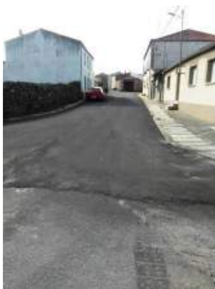
Renovación de la red de servicios y firme de la C/Empedrada.
