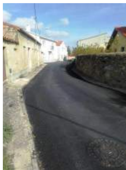
Renovación de la red de servicios y firme de la C/Pozo Arriba.
