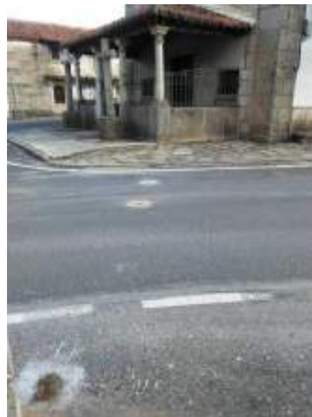
Instalación de un cierre en la ermita como adaptación al recorrido de las capeas urbanas.
