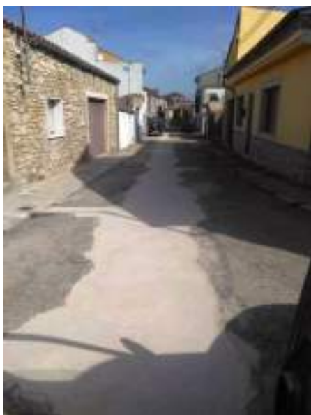
Renovación parcial de la red de servicios y firme de la C/Larga.
