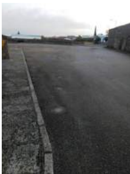
Instalación de toma de agua para abastecimiento ganadero y eliminación de bolardos en el caño de la C/Molino
