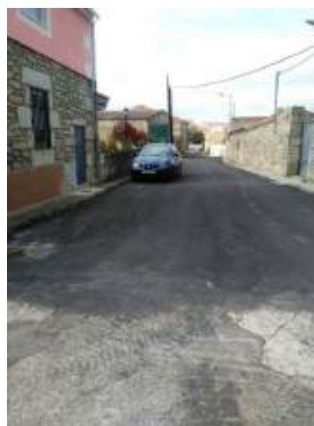
Renovación de la red de servicios y firme de la C/Tenerías.
