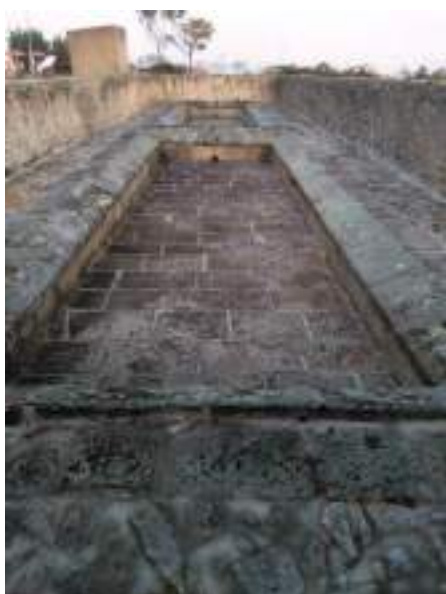
Limpieza de las pozas de la C/ Molino
