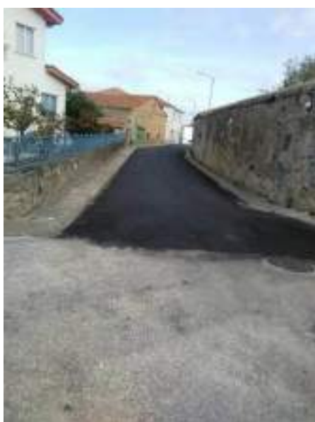
Renovación de la red de servicios y firme de la C/Paz.
