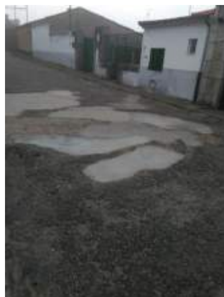
Picado y bacheado de diversas calles
