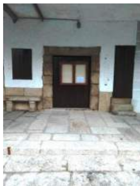
Pintura puerta toriles y acceso al palco.
