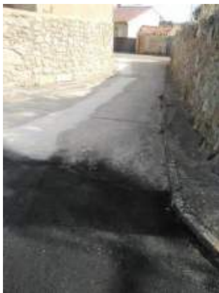
Renovación el desagüe en la travesía entre la C/Plazuela y C/ Pozo Arriba
