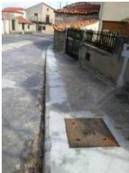
Soterramiento de red de alumbrado en la calle Fuente Abajo para evitar dos postes en la acera.
