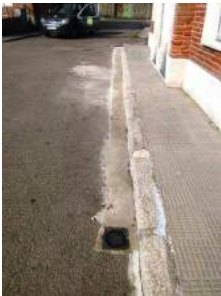
Instalación de un sumidero para eliminar la acumulación de agua en la calle Barrio Rodeo.
